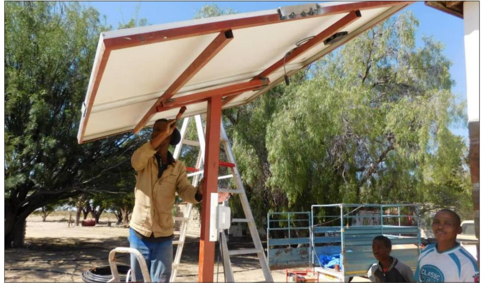
Wie die Wasserpumpe, muss auch die Solarkollektoren gegen Diebstahl gesichert werden. Dies geschieht mit Hilfe von Stahlwinkel.
